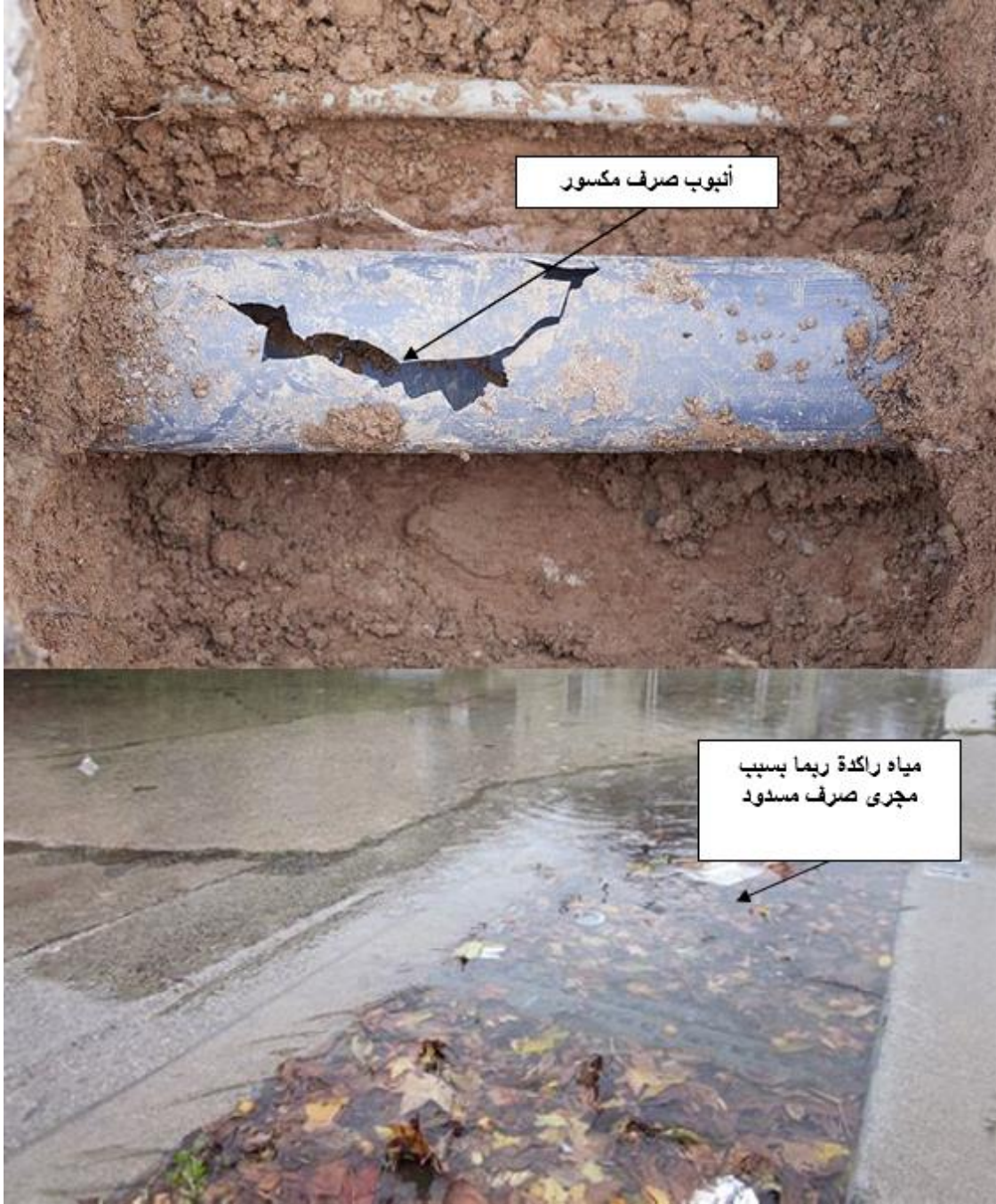
الشكل (٣-٤) عيوب مصارف مياه الأمطار.
