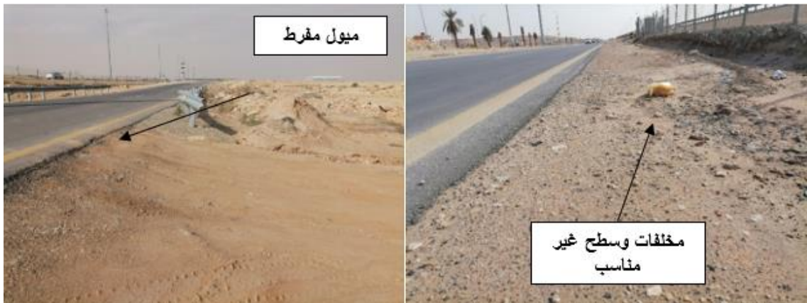
الشكل (٢-٣) عيوب أكتاف الطريق غير المُعبدة.
