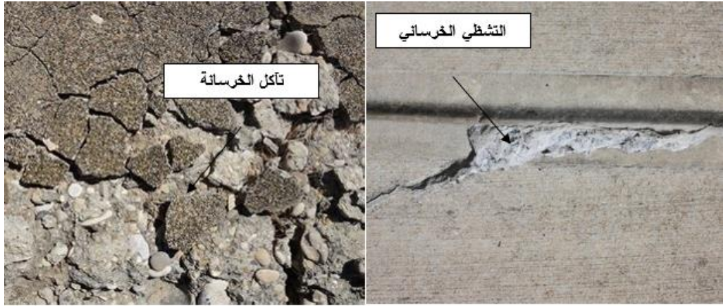
الشكل (٤-٣) عيوب الجدران الاستنادية.
