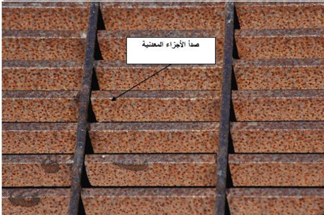
الشكل (١٧-٣) عيوب حوض تجمع مياه الصرف.
