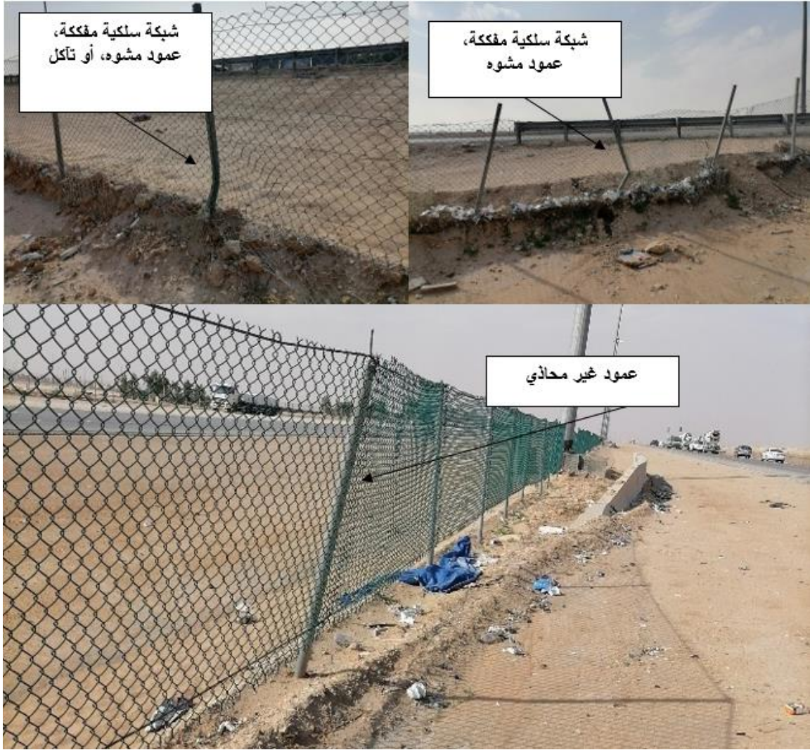
الشكل (١٠-٣) عيوب التسييج.
