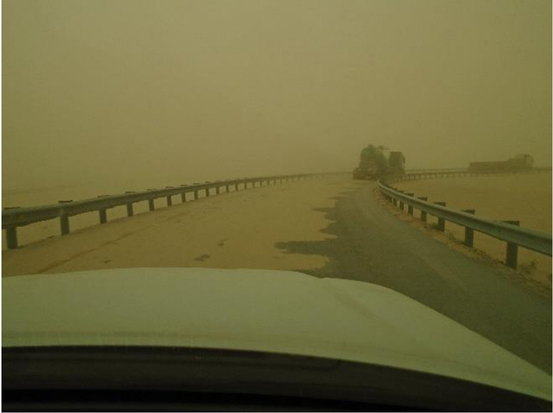
الشكل (٣-٢٧) الفشل في تثبيت الرمال.
