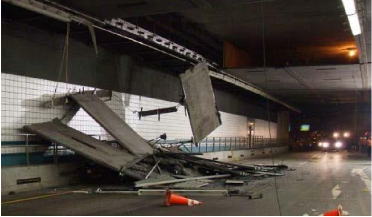
الشكل (٧-٢٢) يجب فحص العناصر العلوية مثل ألواح السقف لمنع وقوع حوادث مميتة.
