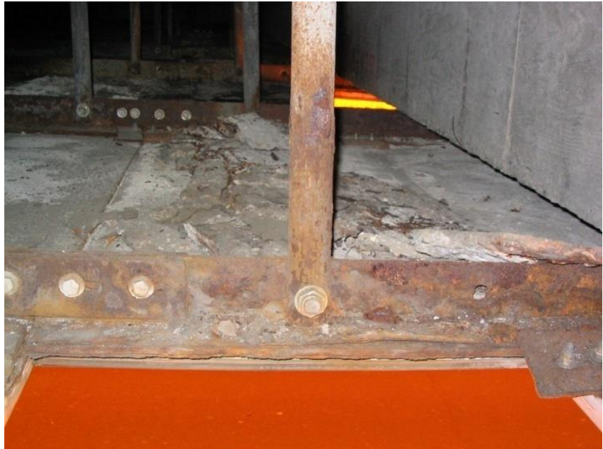
الشكل (٧-٢٤) تُظهر حوامل التعليق وعوارض السقف صداً متوسطاً إلى شديد وانهيّار طفيف في القطاع.
