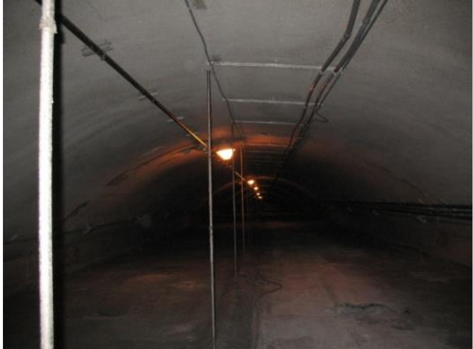
الشكل (٨-٤) منظر لطلاء أسمنتي مطبق على ممر مقوس (NCHRP, 2010).
