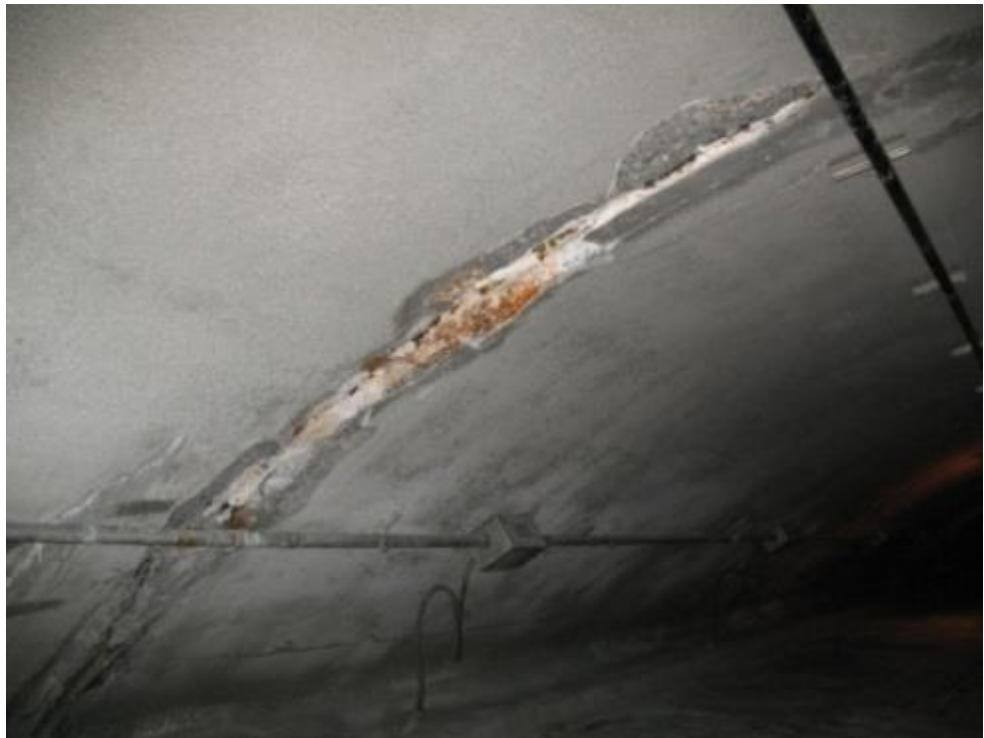
الشكل (٨-٥) تسرب في فواصل الانشاء من خلال الطلاء الأسمنتي (NCHRP, 2010).
