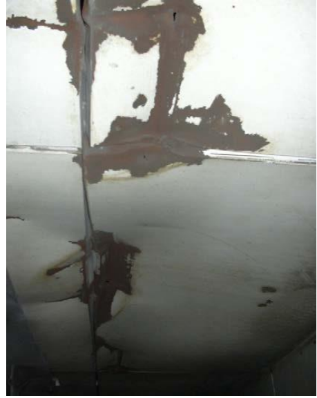
الشكل (٧-٢٦) أمثلة على التشطيبات المعمارية التالفة والبالية على الجانب السفلي من الأسقف - ألواح السقف المعدنية التالفة.
