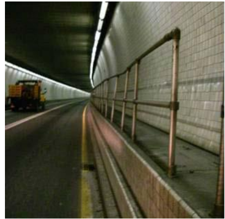
الشكل (٣٧-٧) حاجز مشاة منحنى مع مكونات مفقودة من الحاجز.
