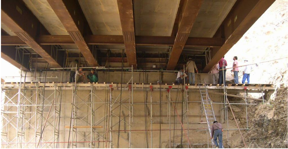
الشكل (٢-٥) رفع سطح الجسر لتنفيذ استبدال المحمل.
