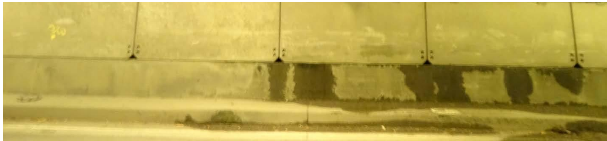
الشكل (٧-٣٥) حواجز مرورية تشير إلى انتشار الرطوبة والبقع الناتجة عن التآكل.
