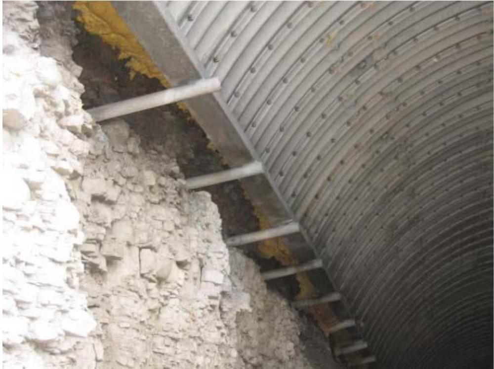
الشكل (٥-٧) ألواح البطانة الحديدية الموجودة أعلى خط الينابيع.
