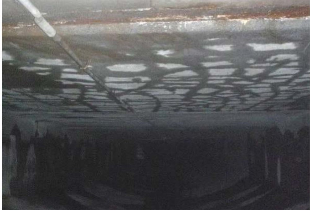
الشكل (٧-٢) شقوق على شكل نمط أو خريطة على الجانب السفلي للبلاطات الخرسانية المقلوبة.
