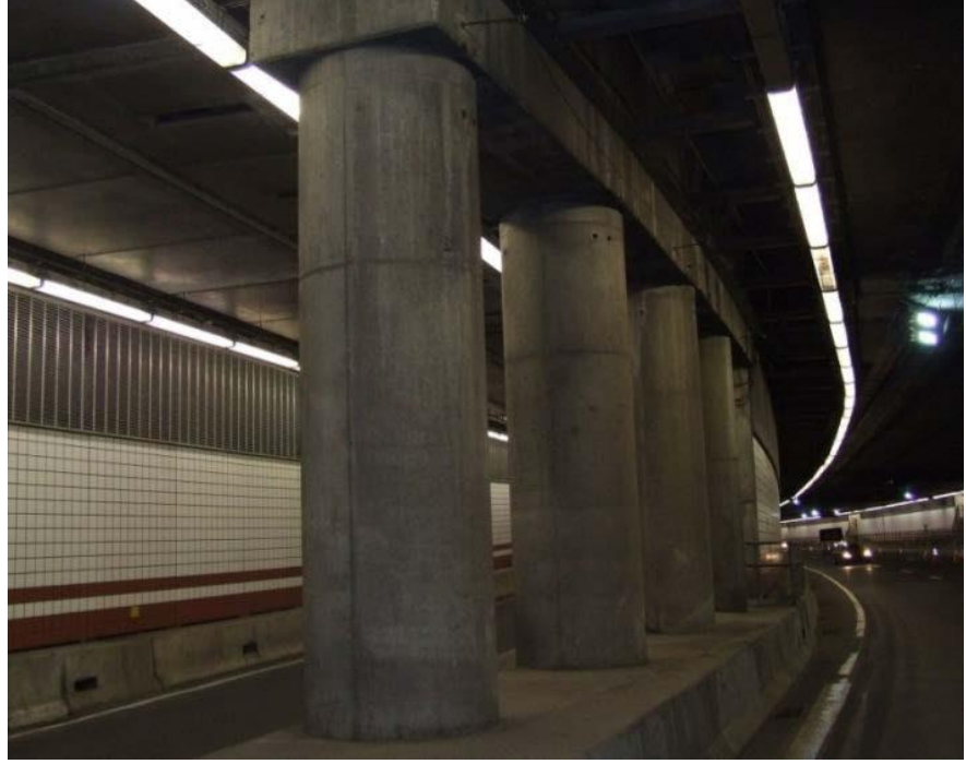
الشكل (٧-١٧) الأعمدة ذات الرؤوس المنحنية.
