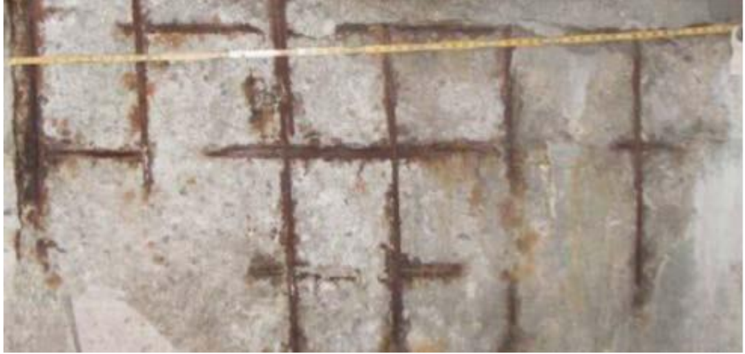
الشكل (٧-٣) حالة التشطي للخرسانة مع حديد التسليح المكشوف.
