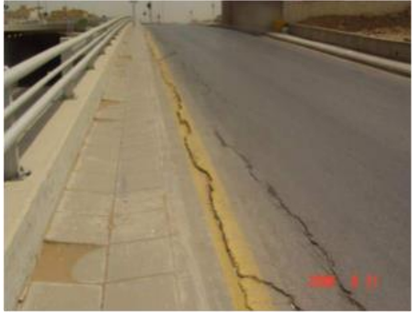
الشكل (٣-٨) التسوية في الطبقة الإسفلتية الموازية للجدار الداعم.
