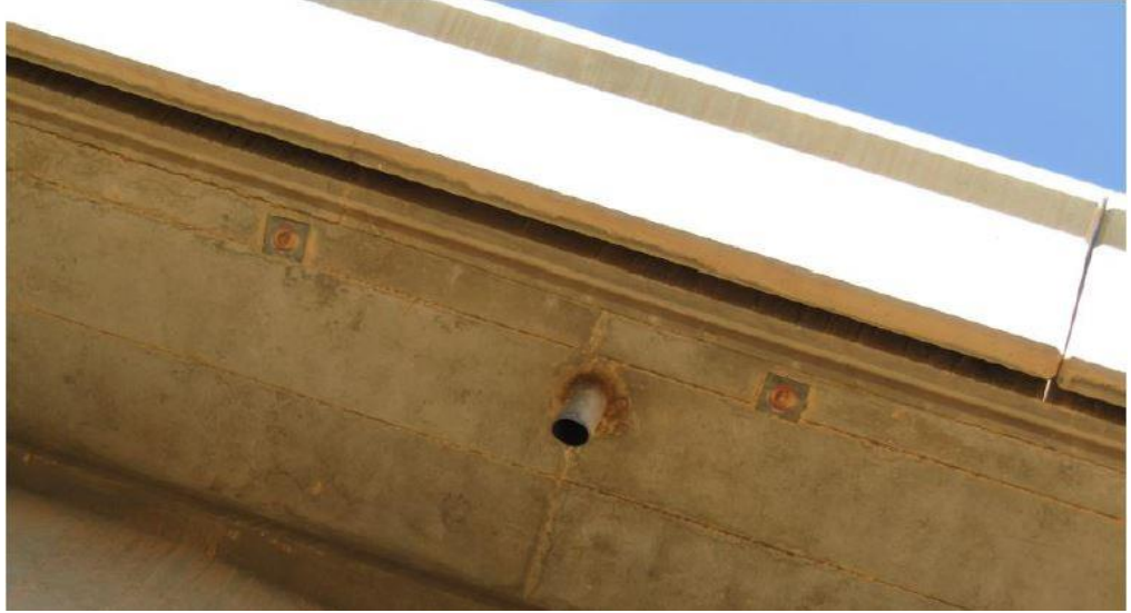
الشكل (٤-١) التصريف من خلال سطح الجسر من الخرسانة المسلحة.
