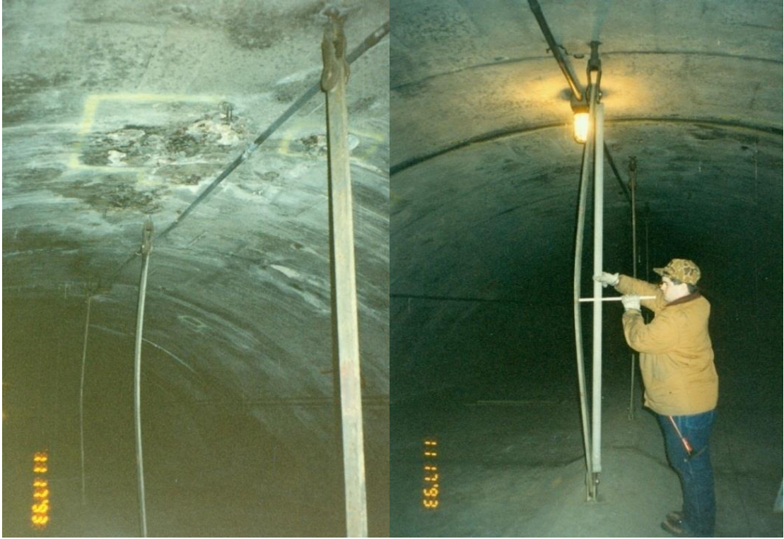
الشكل (٧-٢٣) علّاقة بلاطة السقف المنحنية
