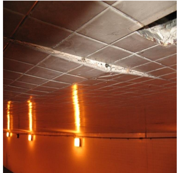
الشكل (٧-٢٧) أمثلة على التشطيبات المعمارية التالفة والبالية على الجانب السفلي من الأسقف - بلاط السيراميك التالف.
