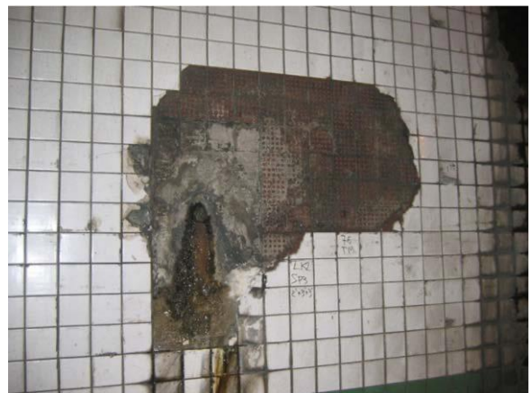
الشكل (٧-١٠) تسربات المياه من خلال بطانة النفق وبلاط الجدران المفقود.
