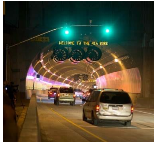
الشكل (٧-٢٠) صورة لنفق مشطب بألواح معدنية تغطي بطانة الخرسانة.
