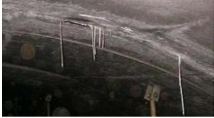
الشكل (٧-٤) التشقق والتزهير المتوسط الموجود على الجانب السفلي من بطانة النفق.
