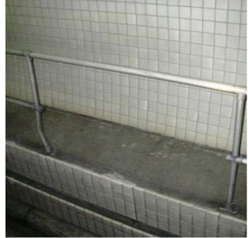
الشكل (٣٦-٧) دعامه منحنية وحاجز مفقود في المنتصف.
