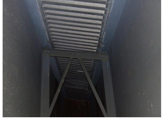
الشكل (١٥-٧) فتحة عارضة السقف النموذجية.
