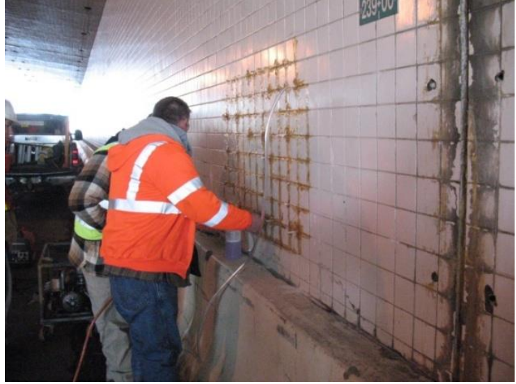
الشكل (٨-٨) الحث الفراغي بميثيل ميثاكريلات (NCHRP, 2010).
