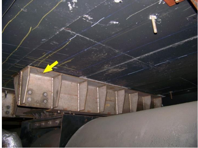
الشكل (٣١-٧) مسمار مفقود في دعامة المروحة الطولية.
