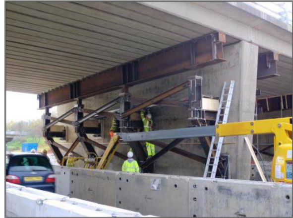
الشكل (٥-٤) رفع عوارض الجسر في نفس الوقت باستخدام عارض إضافي
